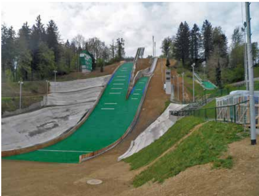
Slika 7. Smučarska skakalnica HS70m v Velenju, zgrajena leta 2017 (na sliki levo).
