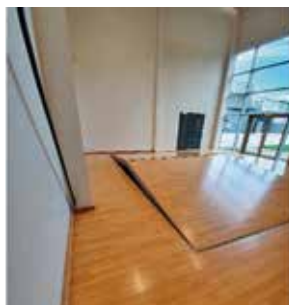
Prilagodljiva izvedba športne opreme: hidravlični mehanizem dvigne parket, pod njim je telovadna jama za doskoke.
