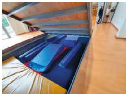
Prilagodljiva izvedba športne opreme: hidravlični mehanizem dvigne parket, pod njim je telovadna jama za doskoke.
